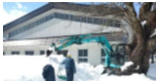
体育館のまわりを重機で除雪
